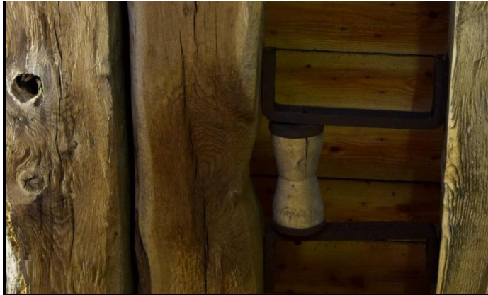
Rolle für das Glockenseil, ermöglichte das Läuten von der unteren Etage des Turms.
